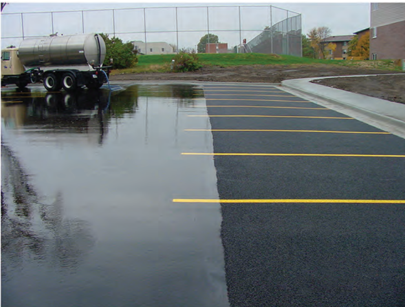
Plastik karışımı asfalt otopark uygulama alanı
